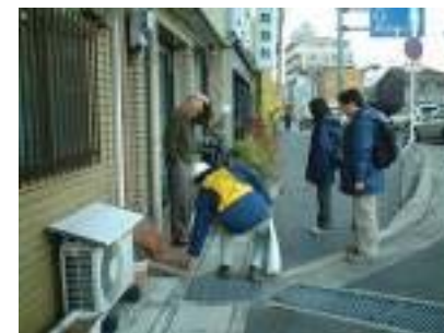
【現地調査状況】
