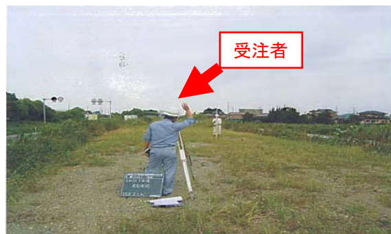
(現場状況の照合を実施)
