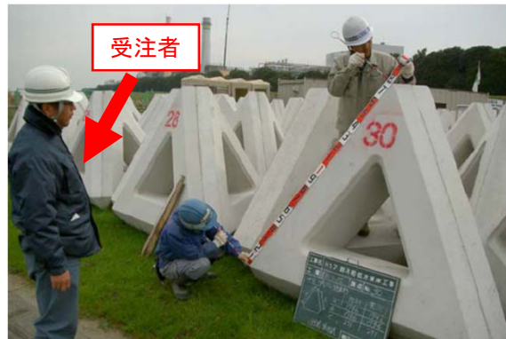
(根固めブロックの材料確認)
