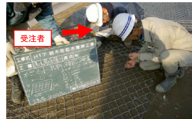
(河川護岸用かごマットの材料確認)
