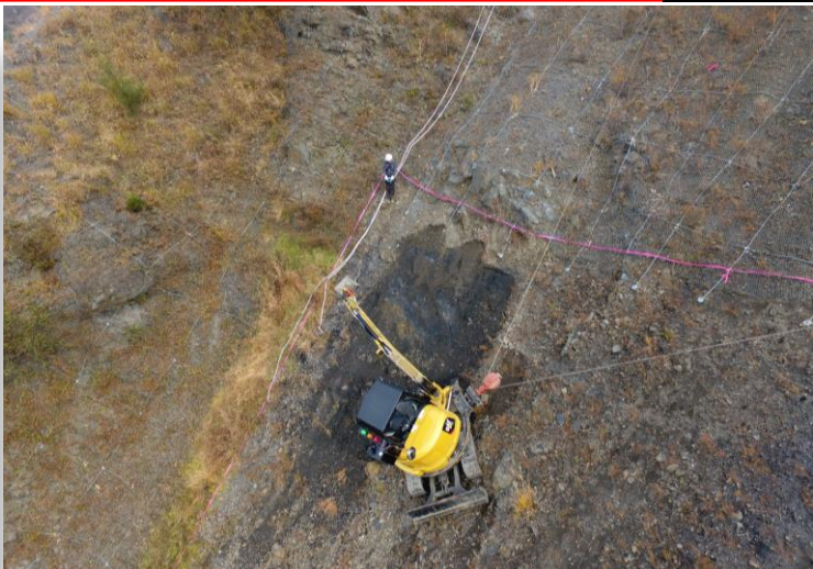
☆セーフティークライマーによる斜面整形状況 ※写真中央やや上部の安全な箇所にオペレーター
