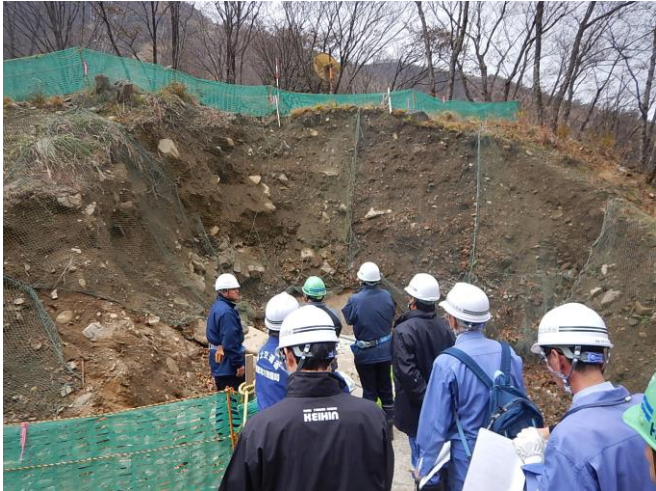
掘削法面の点検をしています
