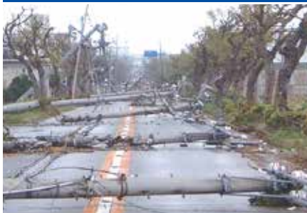
電柱の倒壊による道路閉塞
