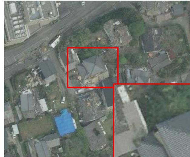
平成28年熊本地震（益城町役場周辺）
