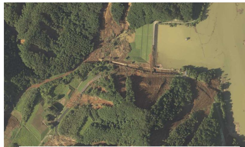
北海道厚真町字幌内（厚真ダム）周辺 [9月6日撮影、（発災1日目、9月7日提供）]
