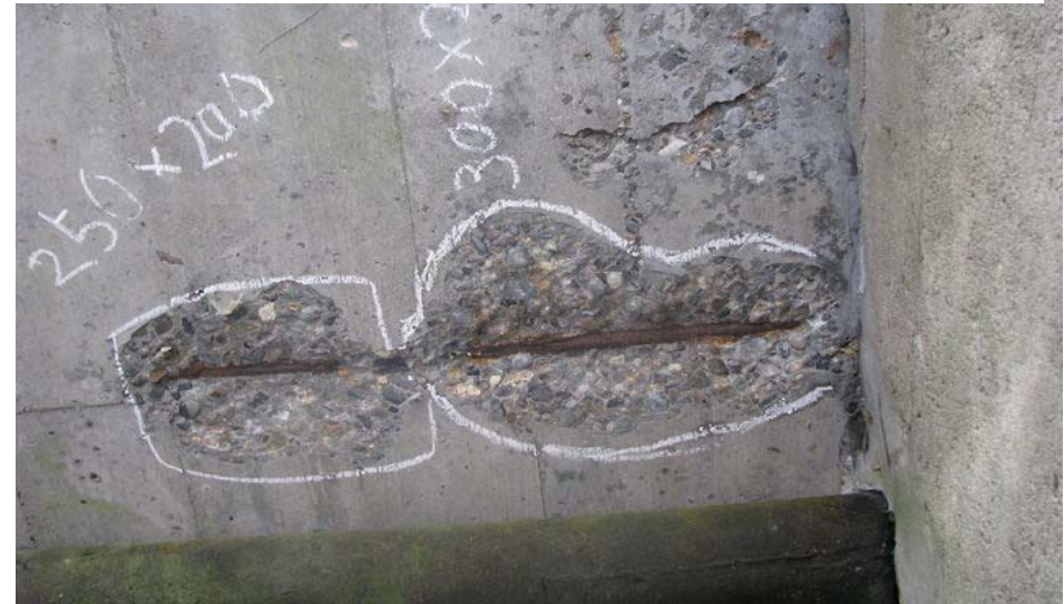
施工時の鉄筋 かぶり不足による
