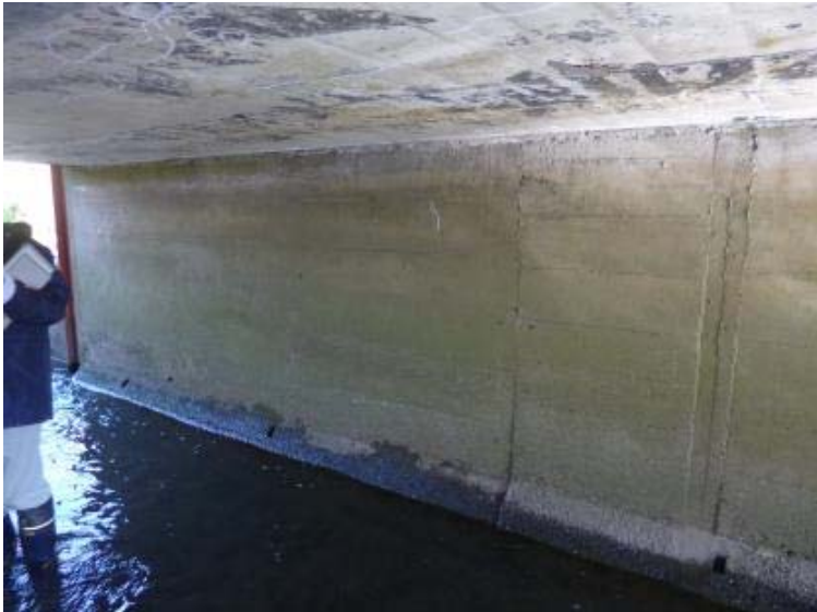
打継ぎ部の損傷
