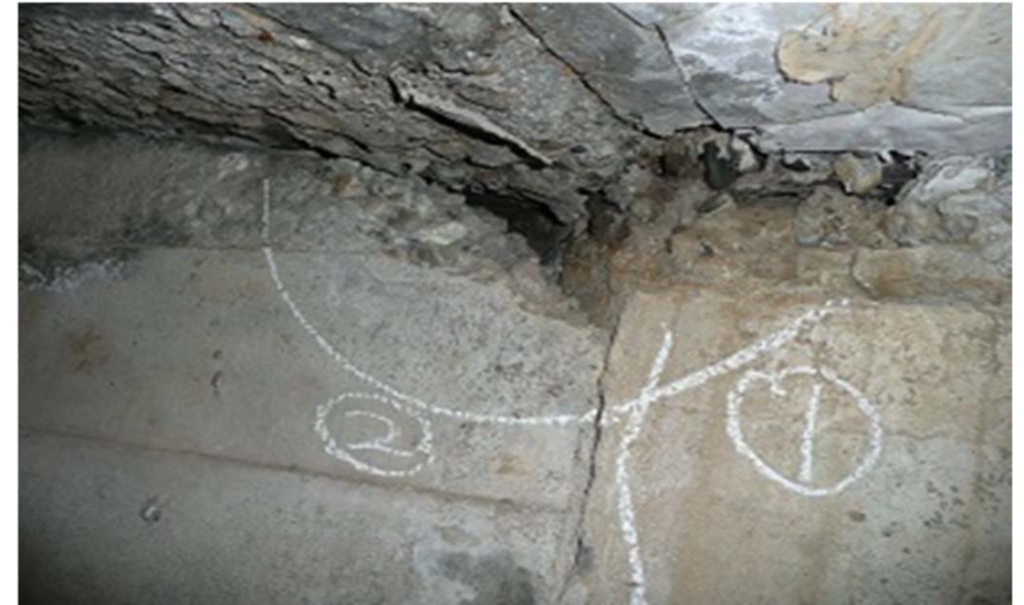
打継ぎ部の損傷
