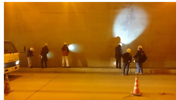
点検実習(打音点検・クラック調査)
