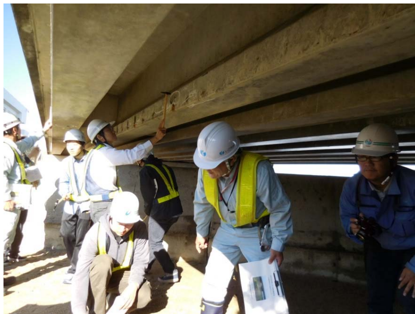
打音検査状況
