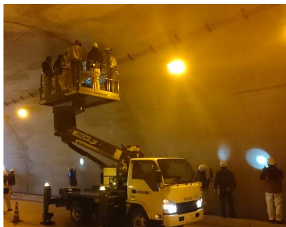
高所作業車による近接点検
