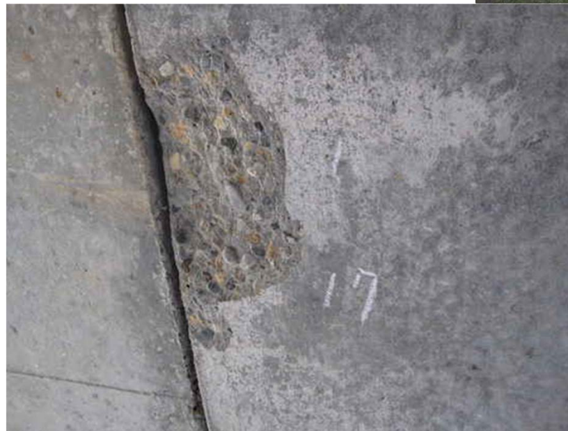
主桁(床板)損傷状況
