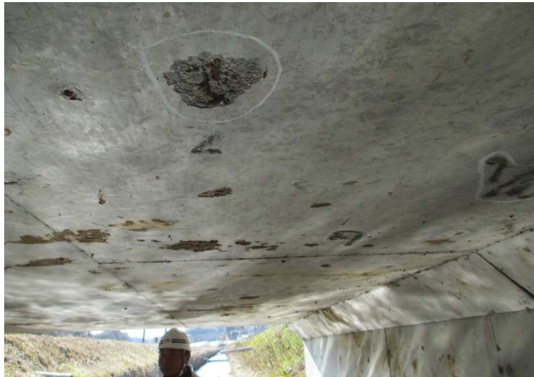
施工時の鉄筋 かぶり不足による
