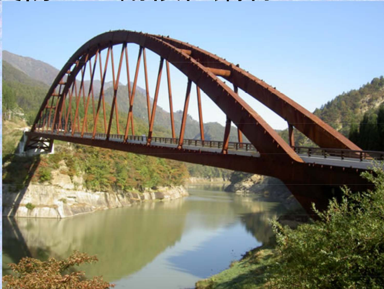
林道大川線 奥裾花大橋
