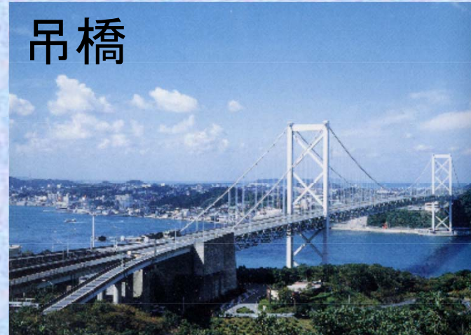
関門橋(関門道)
