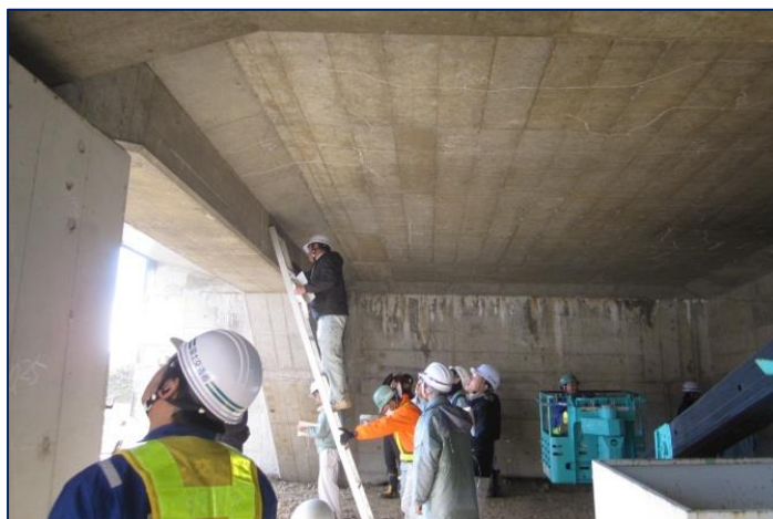
梯子、高所作業車を用いた近視点検
