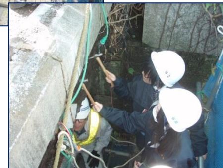
主桁の点検体験
