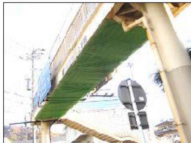
防護ネットによる緊急措置
