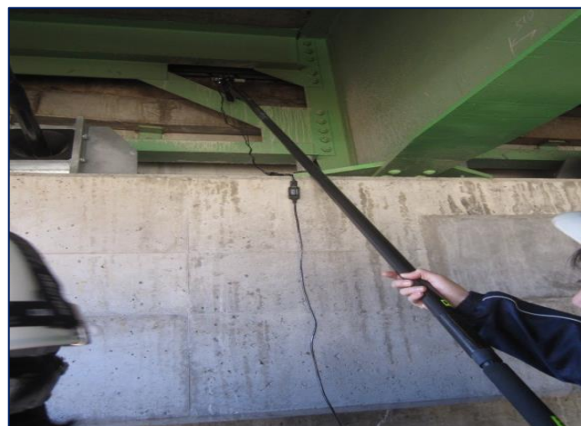
ポールカメラによる点検
