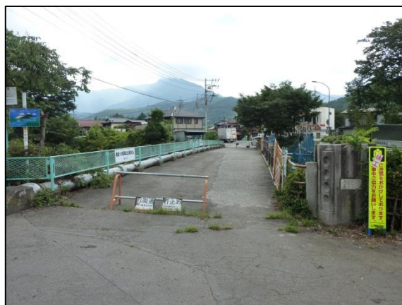
車両通行止め措置を実施
