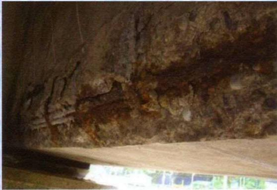
主桁の損傷状況(歌高架橋)
