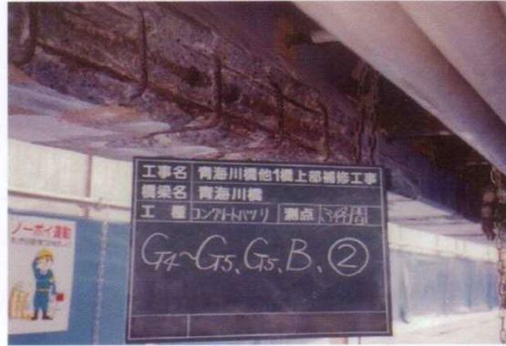
内部鉄筋(PC鋼材)の破損状況(断面欠損)(青海川橋)
