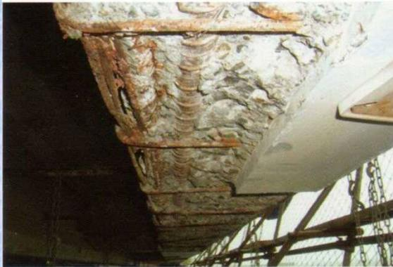
内部鉄筋(PC鋼材)の腐食状況(有間川橋)
