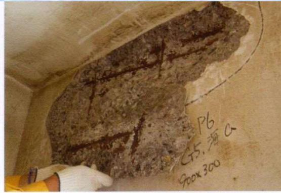
主桁の損傷状況(弁天大橋)
