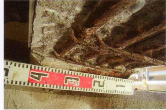
内部鉄筋の腐食状況(断面欠損)(境橋)
