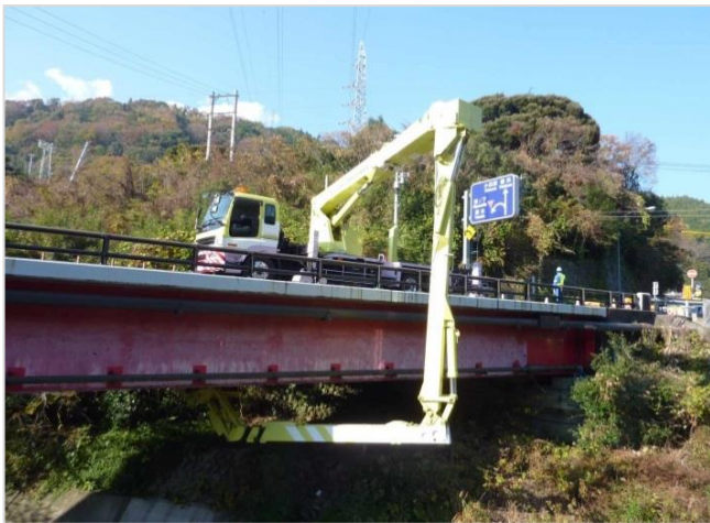
橋梁点検車による点検
