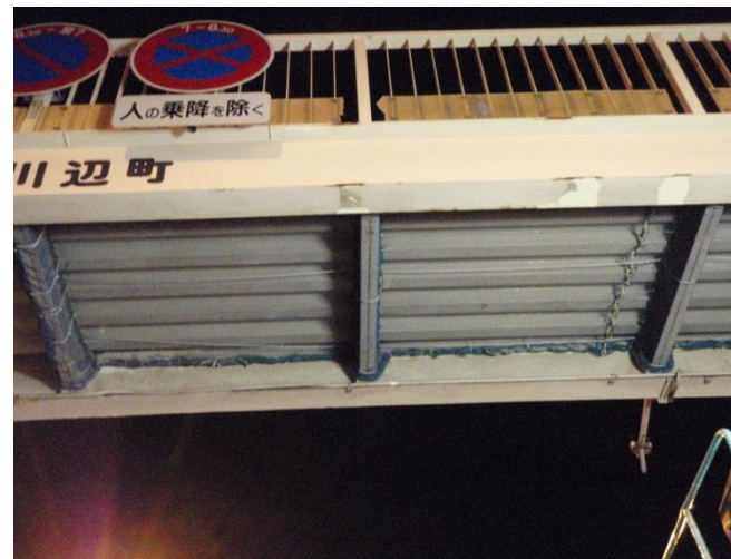
防護ネットによる緊急措置
