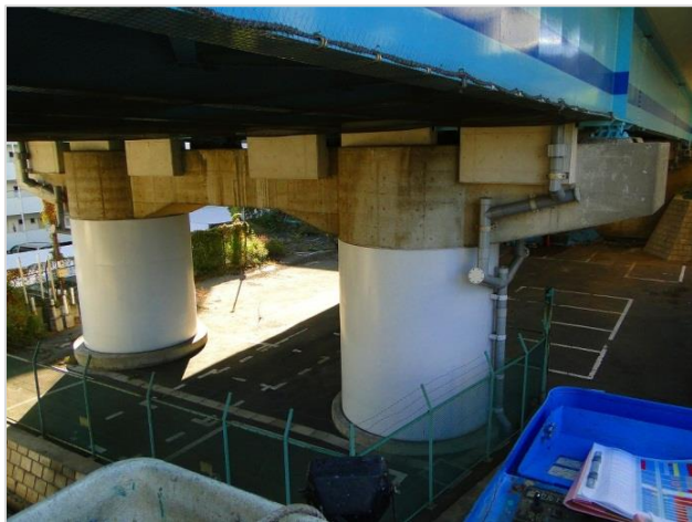
橋脚の巻き立て補強
