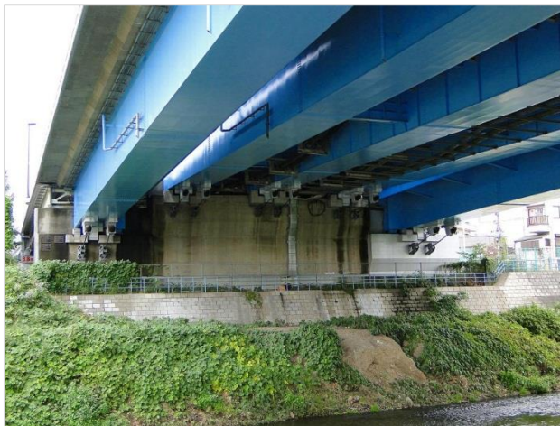
落橋防止装置の設置
