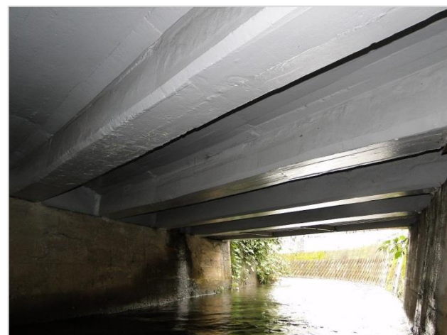
コンクリート桁の補修
