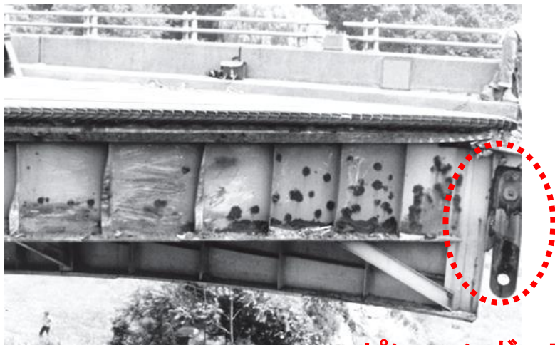
ピン・ハンガー部の脱落
