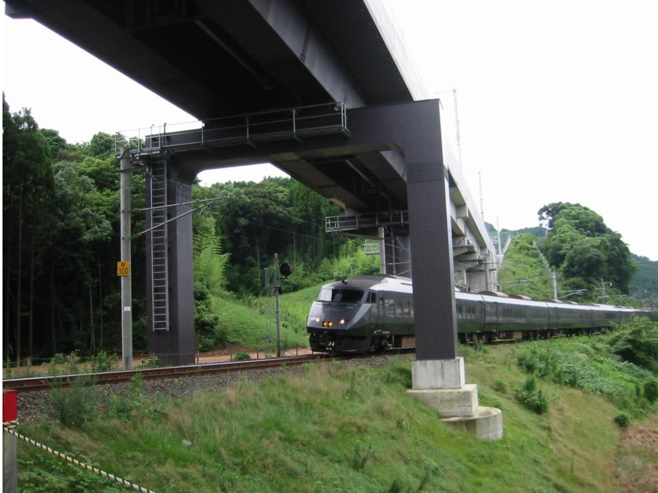
ラーメン橋脚（九州新幹線）
