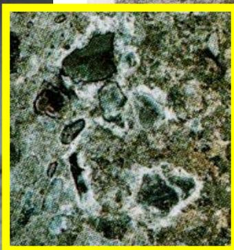
PC鋼材方向が卓越したひび割れ
