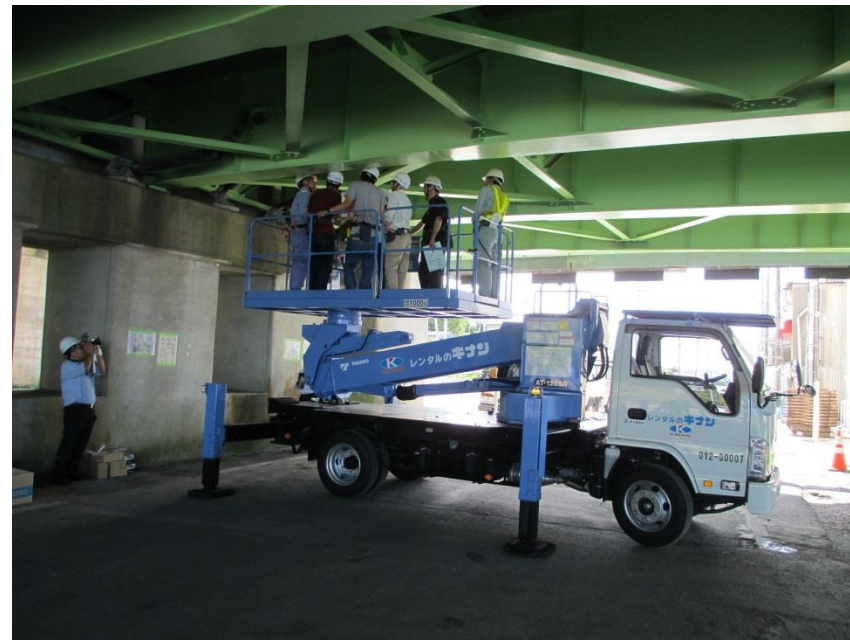
高所作業車による近接点検 (床版・鋼橋桁部)
