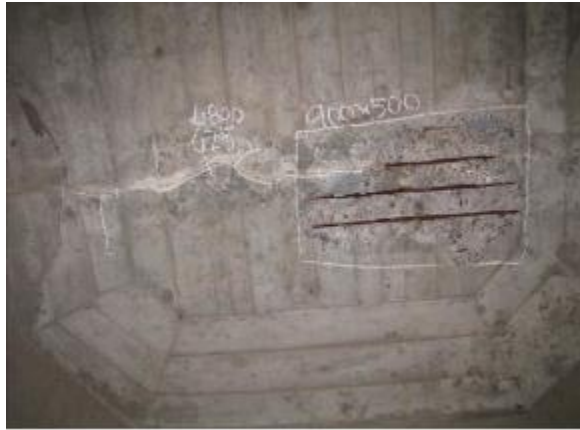
床版の鉄筋露出・遊離石灰
