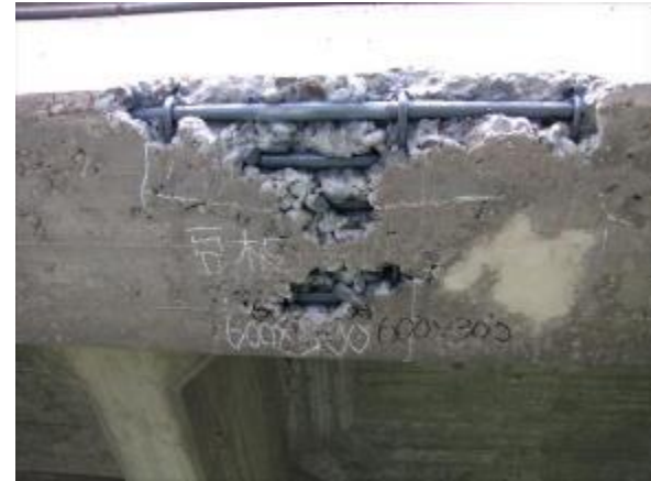
主桁の剥離・鉄筋露出
