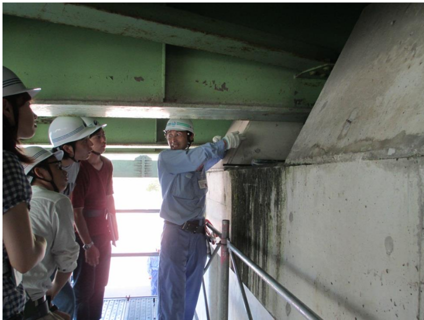
足場を利用した近接点検 (支承部)
