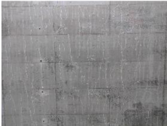
床版の鉄筋露出・遊離石灰
