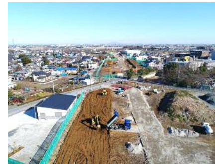
越谷市増森における工事状況
