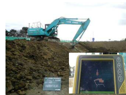
MG(※2)バックホウによる法面仕上げ
