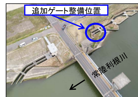
常陸川水門魚道
