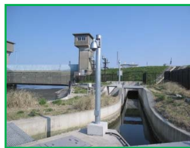
③常陸川水門(監視装置)
