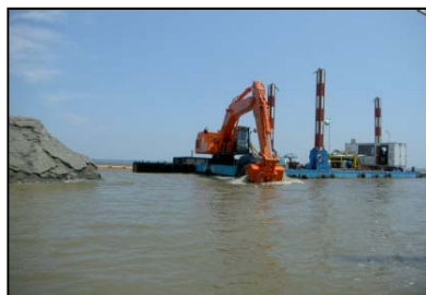
航路浚渫の様子
