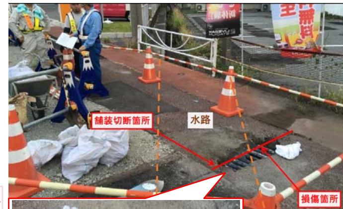
事故発生状況
