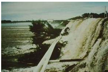
明野町赤浜地先の越水状況
