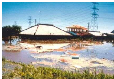
母子島の浸水状況
