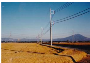
移転地の造成工事
