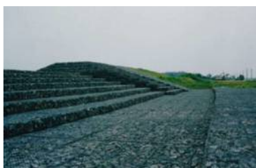
越流堤「キヌマット」施工
