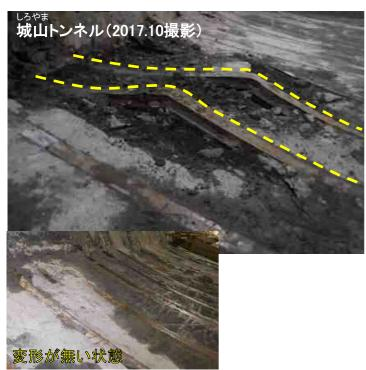
脆い地山のため、トンネル内に想定以上の強い土圧がかかり内空変位が生じた事から、インバートストラットの変形が発生。
