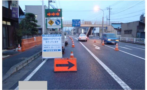
規制材の配置を見直し、導流部の矢印
