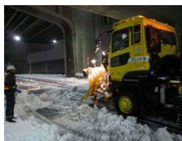
重機による本線車道除雪作業の状況
