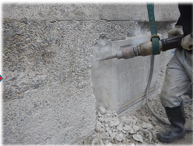
▲昭和39年当時の貴重な銘板を撤去。 上手く取れば再利用する。
