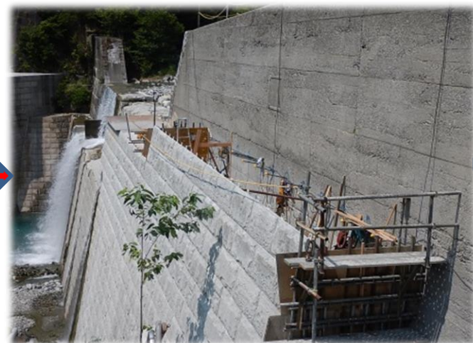
▲残存型枠を使用し腹付けコンクリートを打設していく
