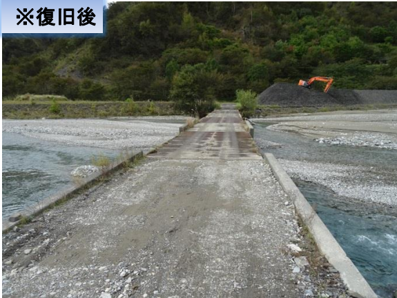
【足尾砂防出張所管内における現在施工中の工事】
