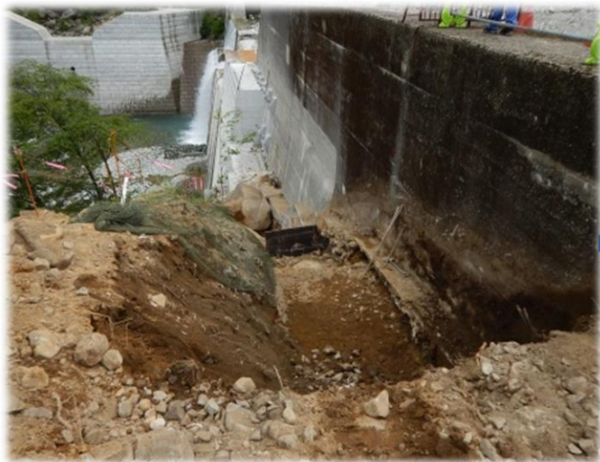
▲下流腹付け部基礎の掘削状況
