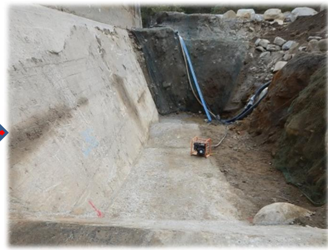
▲これから型枠を建込みコンクリートを打設していく
