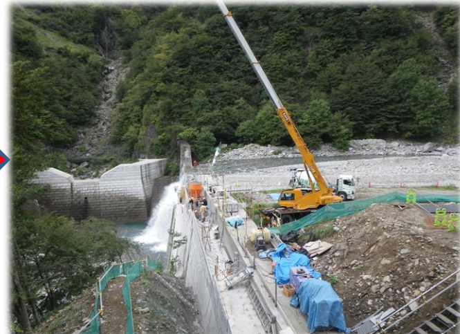
▲下流腹付けコンクリート打設状況
