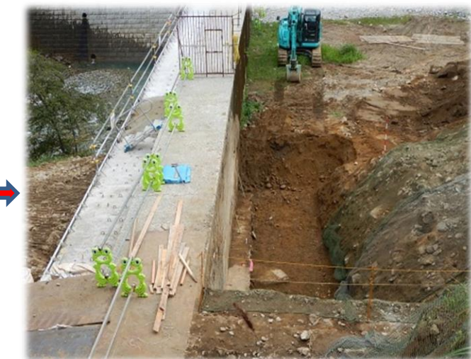
▲上流腹付け部基礎の掘削状況
