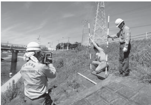
写真-2 タブレットを使用した堤防点検
