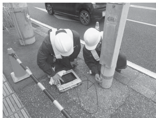
写真－3 非破壊調査の状況
