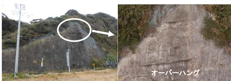
図4 路上からの遠望目視と、UAVからの近接目視
