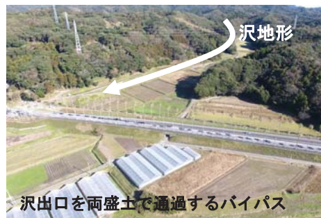
図3 UAVの広域画像（例）
