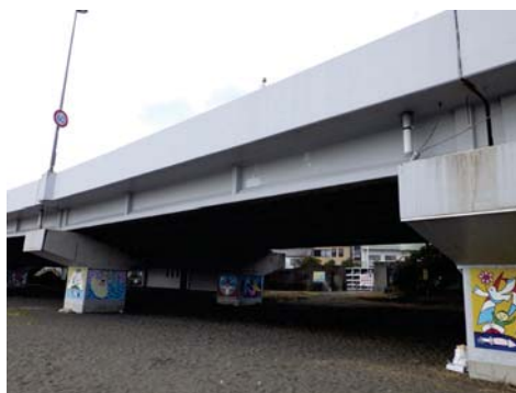
写真-1 調査対象橋梁の状況
