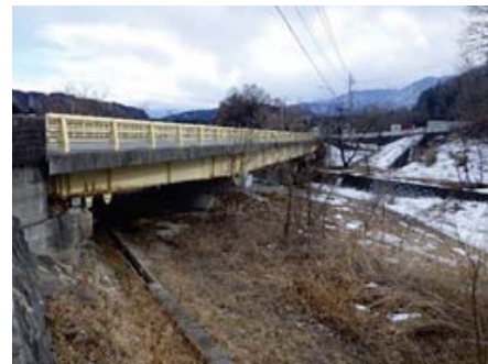
写真-1 調査対象橋梁の状況
