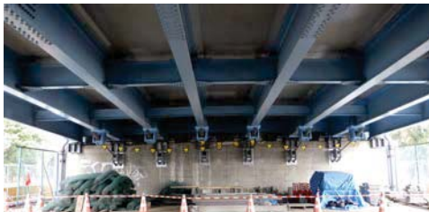
写真-1 桁下状況
