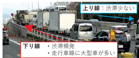
写真-3 当該橋梁付近の状況(昼間の渋滞状況)
