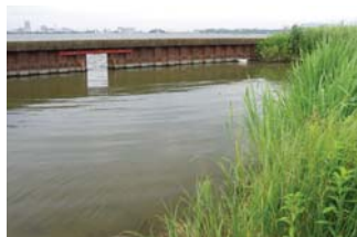
かつては霞ヶ浦の浚渫土仮置きヤードとして使われていたA区間。矢板列の一部を切断・開口し、多様な動植物が生育・生息するワンドを造成。
