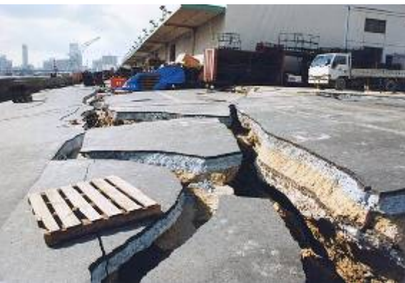
【阪神・淡路大震災時の港湾施設の被災状況】
