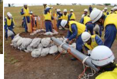
漏水防止工法 （月の輪工）
