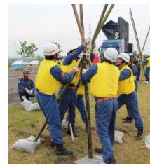
亀裂防止工法 （五徳縫い工）
