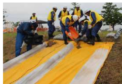
洗掘防止工法 （水防マット工）
