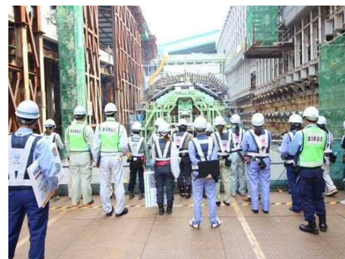
現場点検③
