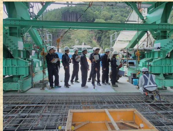
送り出し架設の説明(ワーゲン)
