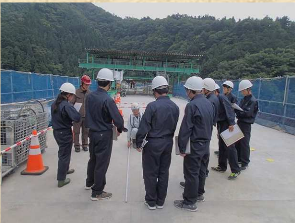
送り出し架設の説明(打設ロッド)
