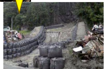
応急復旧工事完了
