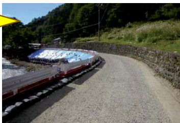
復旧工事完了
