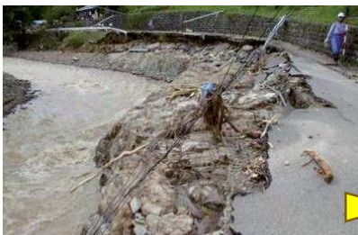
市道芹沢線の被災状況
