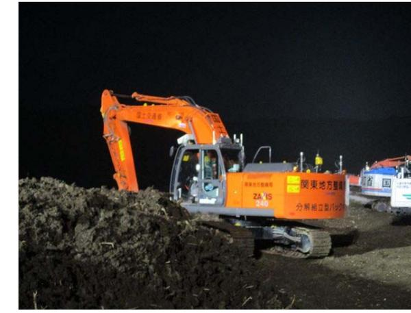
【応急対策班】厚真町幌内橋付近で河道掘削作業(バックホウ)
