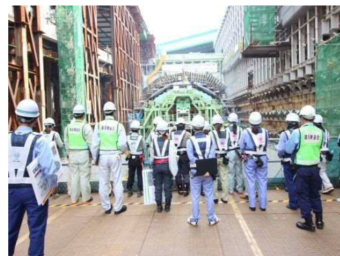
現場点検③
