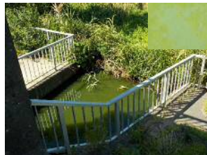
8/27 西浦左岸16.25km付近 手賀第二排水樋管 (レベル3)
