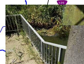
8/17 西浦左岸16km付近 (レベル3)
