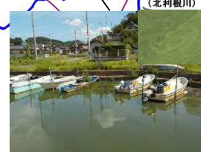
8/18 西浦左岸33km付近 (レベル3)
