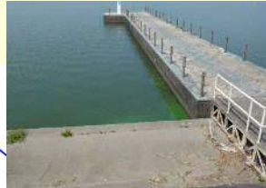
8/13 西浦左岸19.50km付近 (レベル3)
