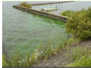
8/30 西浦左岸30.25km付近 (レベル3)
