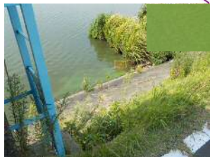
8/31 西浦左岸20.25km付近 (レベル3)
