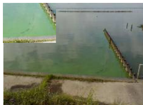
8/21 西浦左岸2km付近 (レベル3)
