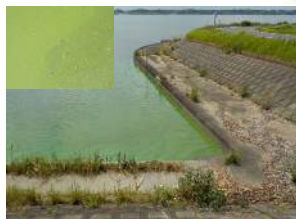
8/21 西浦左岸20.5km付近 (レベル3)
