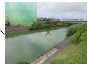
8/21 北浦右岸24.5km付近 山田川河口 (レベル3)
