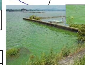
8/14 西浦左岸30.25km付近 (レベル3)
