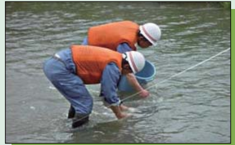
▲定期水質調査
