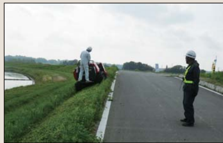
▲堤防除草作業の状況
