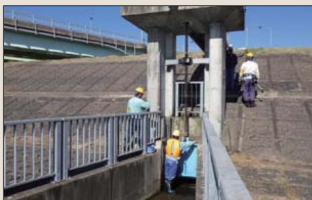
▲河川管理施設の点検状況
