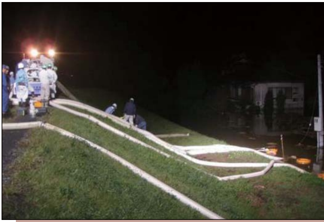
▲ポンプ車活動状況
