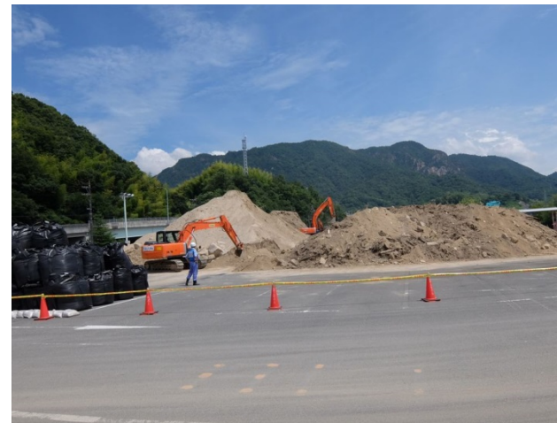
【中国地整_高度技術指導班】 呉市内での土砂撤去等現地確認
