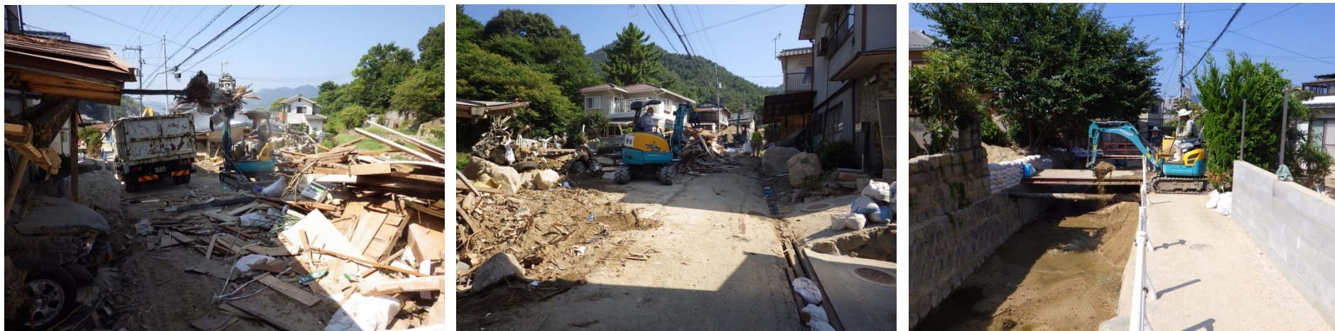
【中国地整_高度技術指導班】呉市内での土砂撤去等作業
