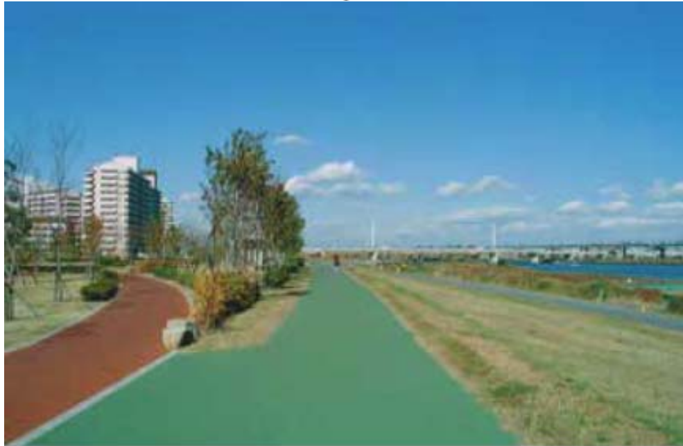
高規格堤防の整備によって堤内地側は堤防とほぼ同じ高さに盛土
