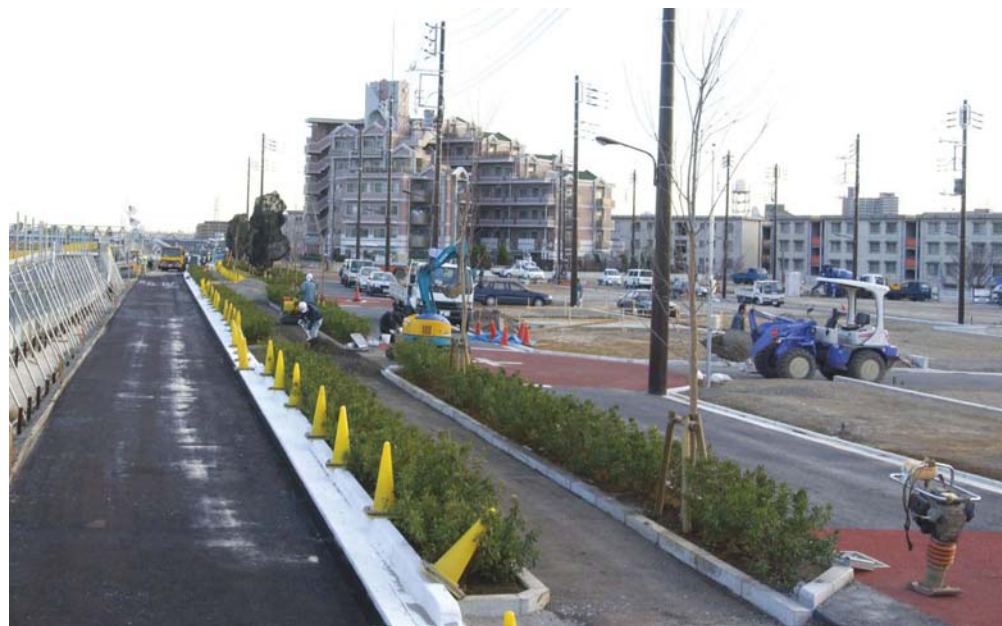
高規格堤防の盛土が完了し、整備が進む街区
