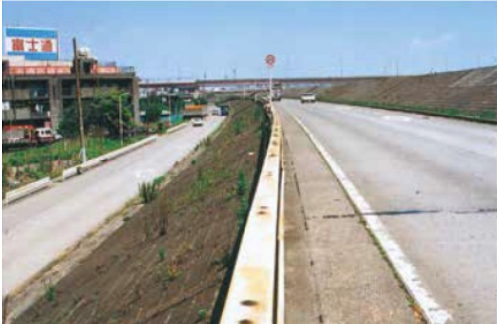
ゼロメートル地帯を守っていた高さ約10mの荒川の堤防
