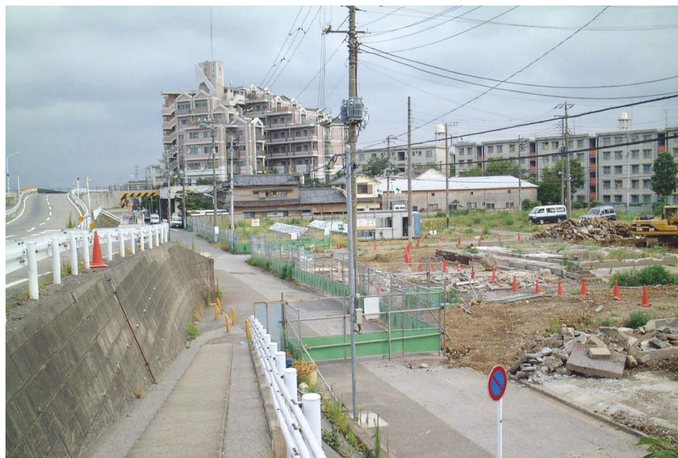
高規格堤防の整備に伴い既設住宅等を一時撤去
