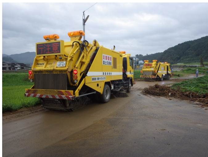
【四国地方_応急対策班】愛媛県西予市内での路面清掃作業
