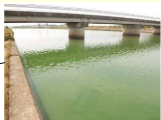
7/19 北浦左岸36km 付近 (レベル2)
