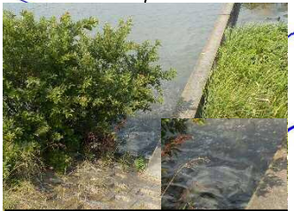
7/19 西浦左岸30km 付近 (レベル1)
