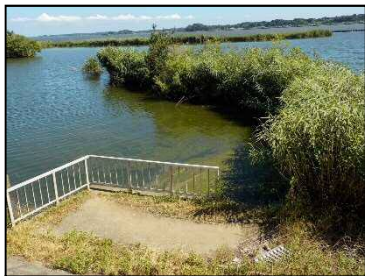
7/2 西浦左岸34km 付近 上高崎揚排水樋門上流側 (レベル3)
