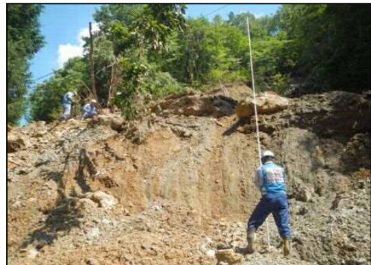
7/16 被災状況確認 (岡山県新見市)
