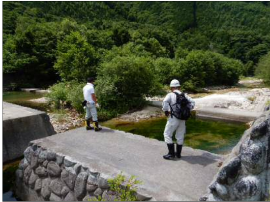
点検状況（横川床固群）
