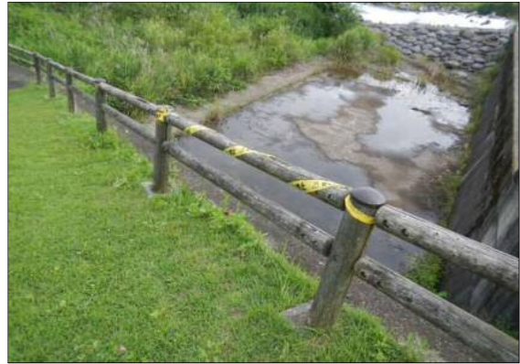
転落防止柵が老朽化しているため、注意喚起テープを貼り付け（大谷川床固群）
