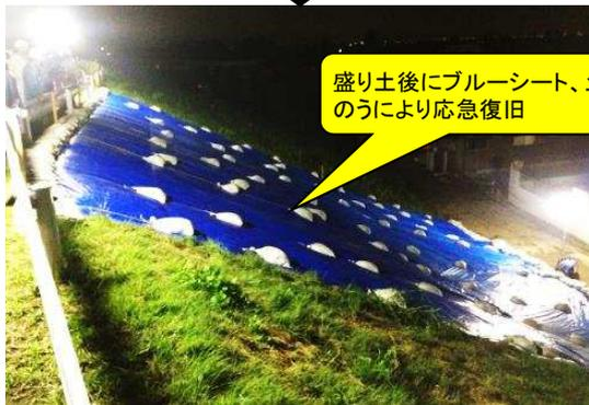
台風後の点検で発見した補修のようす
