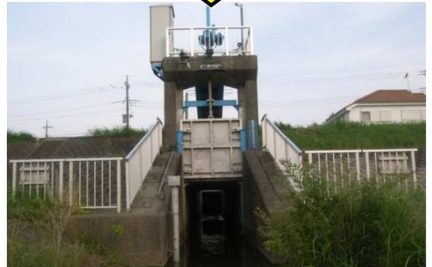
老朽化した樋管のゲートを交換(ステンレス化)
