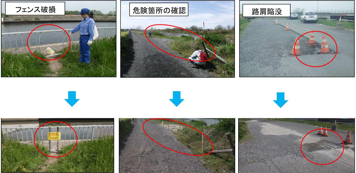
安全利用点検で発見した危険箇所と応急対策のようす(平成29年度ゴールデンウィーク前)
