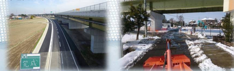
除雪作業の様子
