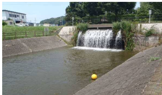
坂川放流口 利水運転時 14m 3 /s導水
