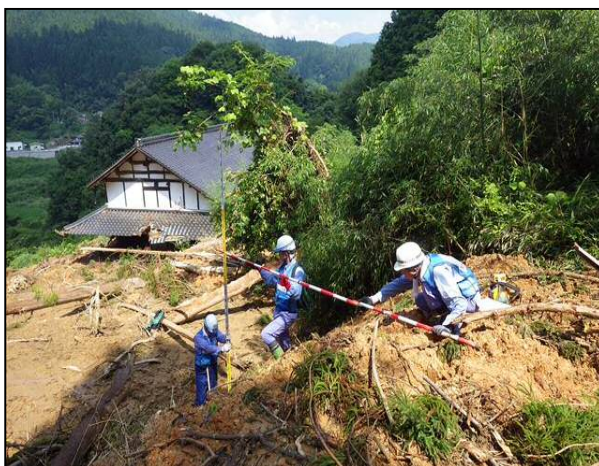
7/15 被災状況確認 (岡山県新見市)
