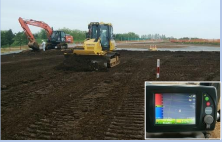
MCブルドーザによる敷均し
