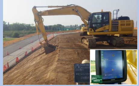
MCバックホウによる法面整形
