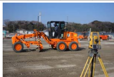
(ICT舗装施工例) MCモータグレーダ下層路盤工
