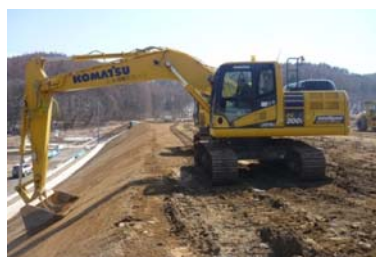
(ICT土工施工例) MCバックホウ法面整形工
