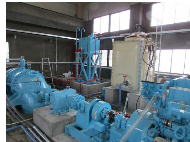
排水ポンプ更新
