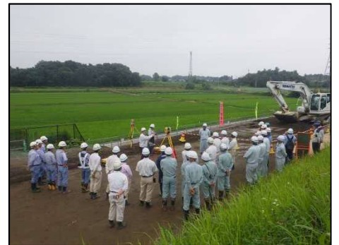
受発注者合同でのICT現場研修会 (見学：LS、MCパッド・ブレード、GNSS締め付け)
